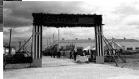
古川工厂1期工程完工（64年）
